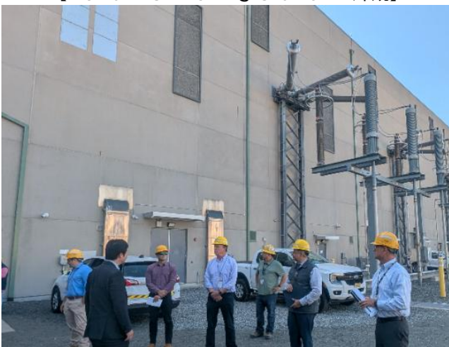
【Newark Switching Stationの外観】
